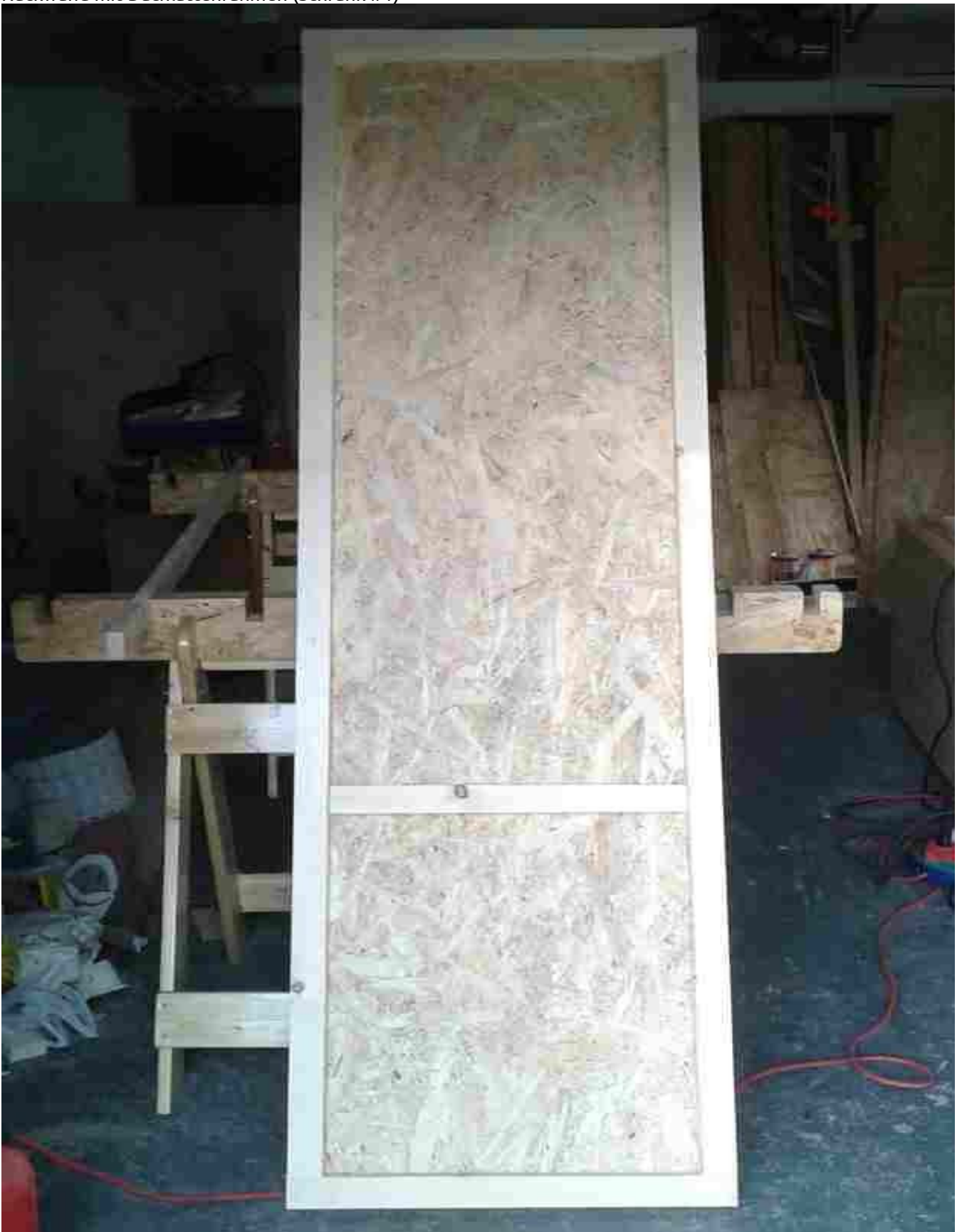
Rückwand mit Dachlattenrahmen (Schrank #1)
