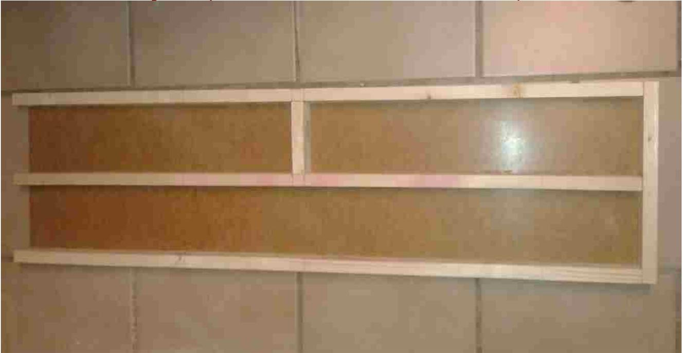
Rückwand und Boden der unteren „Schale“ aufgeleimt und fertig zum Tackern
