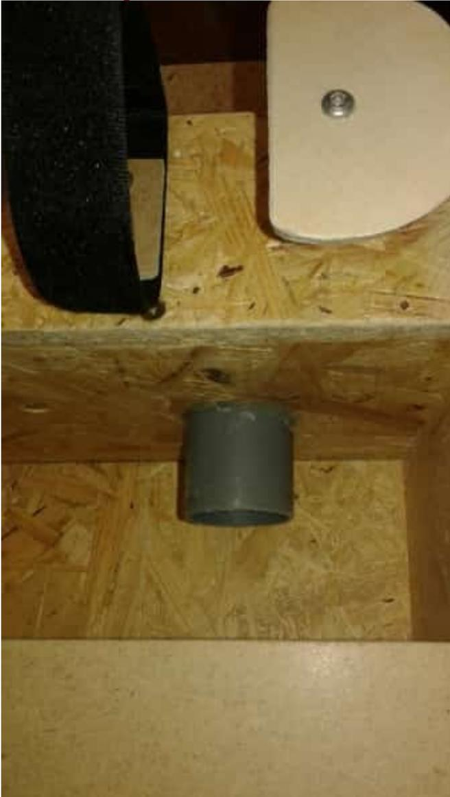
Detail: Hängeleiste und Gegenlager falls es mal an einer einzelnen Leiste hängt
