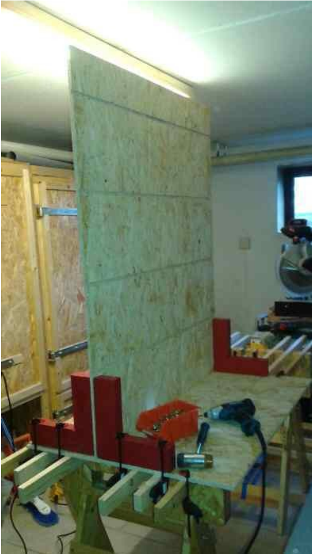
Verleimen und Verschrauben der Bodenplatte mit der senkrechten Wand
