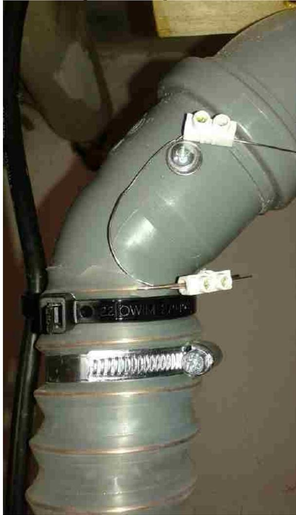
Verschlußdeckel (HT-Muffenstopfen mit Eigenbau-Griff)
