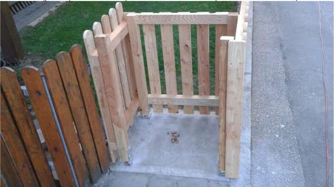
Türe und Dach wurden ebenfalls aus Zaunriegeln und Zaunlatten gebaut und mit Ladenbändern und Kloben bzw. Kreuzgehängen angeschlagen.
