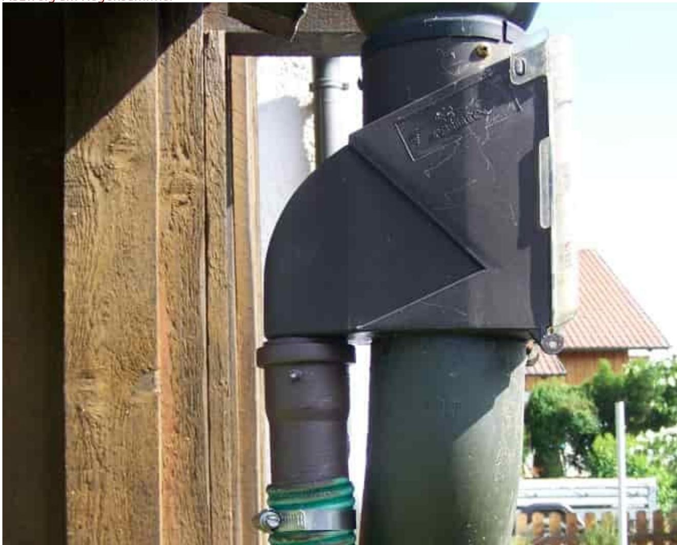
Ein übrig gebliebener 38mm Poolschlauch (recht UV stabil) erhielt auf einer Seite eine Tülle mit 1,5" AG und auf der anderen Seite mit 1,5" Überwurfmutter.
