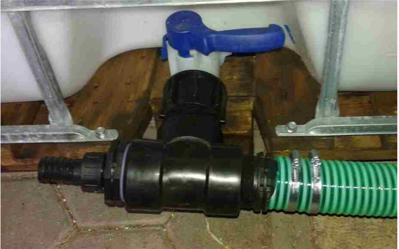
Verbindung der Tanks mit 50mm Schlauch
