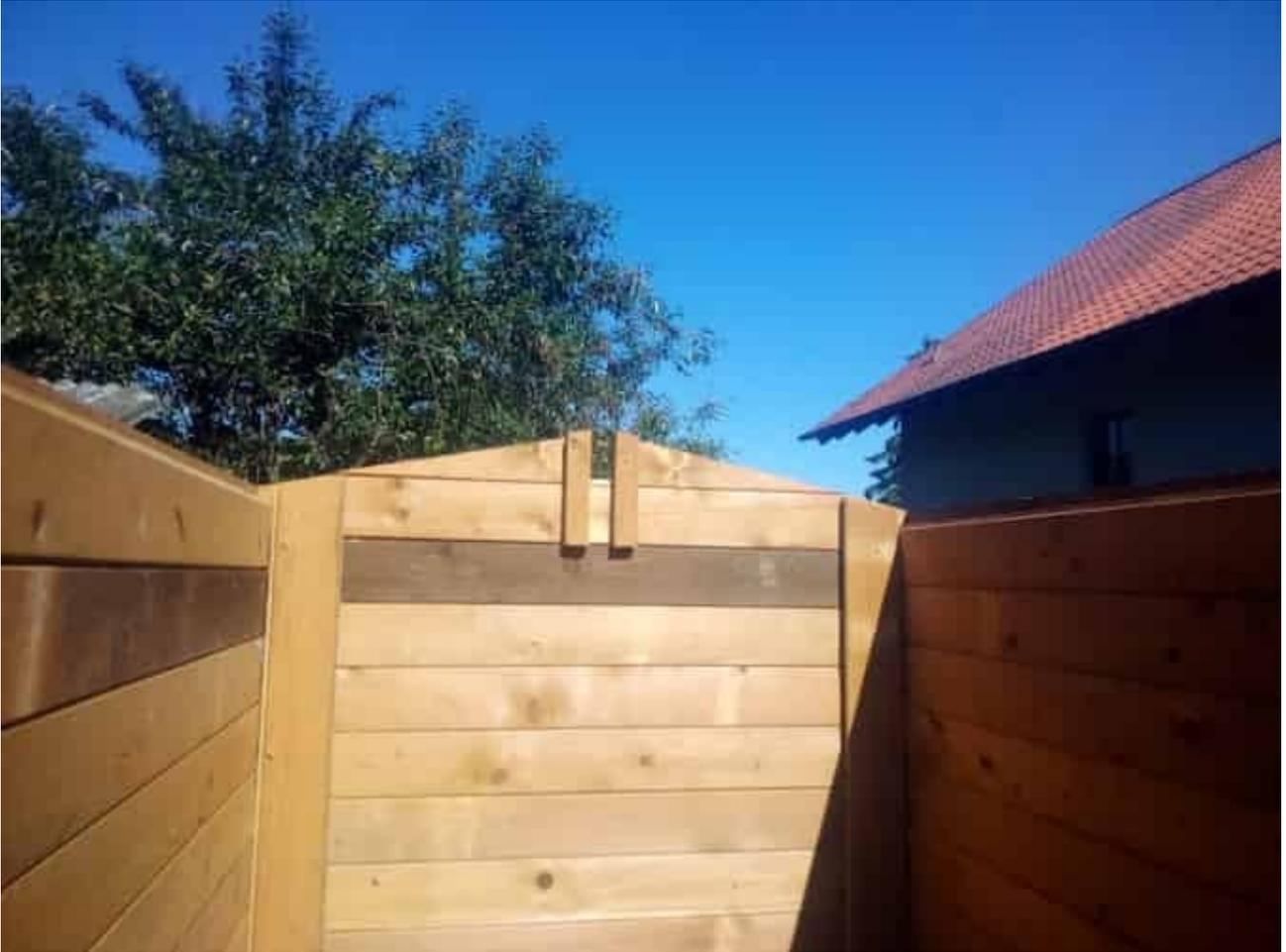
Das Dach wurde mit alten Teilen gedeckt (verschraubt) und dann im montierten Zustand auf den gewünschten Überhang mit der Handkreissäge und Schiene zugesägt.
